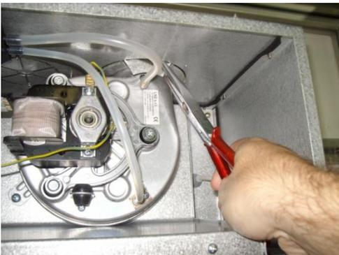
在能启动锅炉且稳定运行时，不要立即弯曲更多不必要的气流限制器。供给燃烧的空气过多会降低锅炉的效率。
